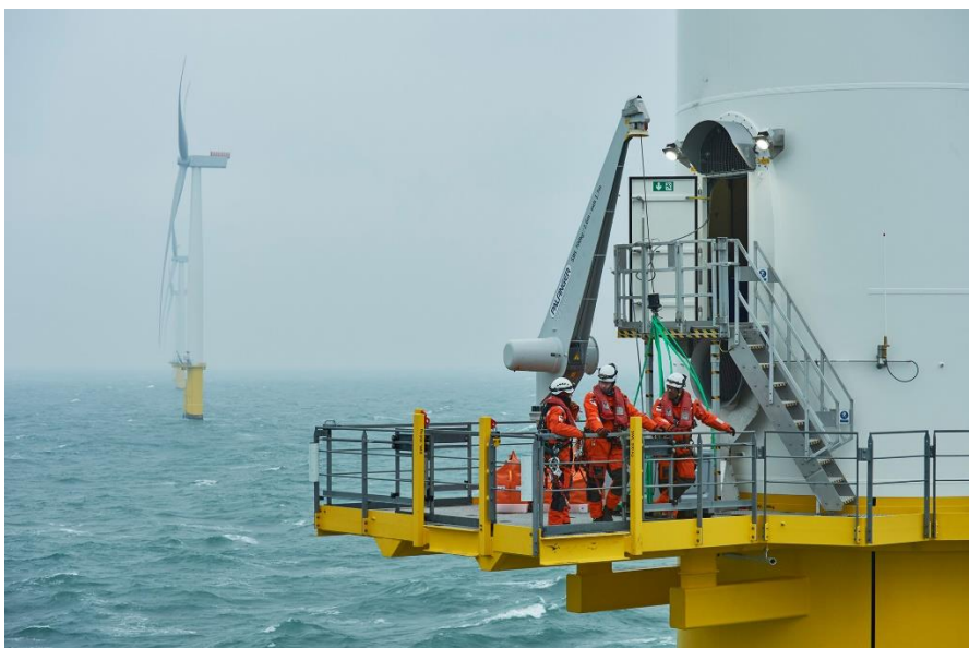
Service Techniker auf S3-Turmsegment. Foto: ©Jan Oelker
