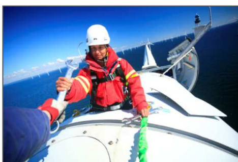
Service- und Reparaturarbeiten an einer Offshore- Windanlage
